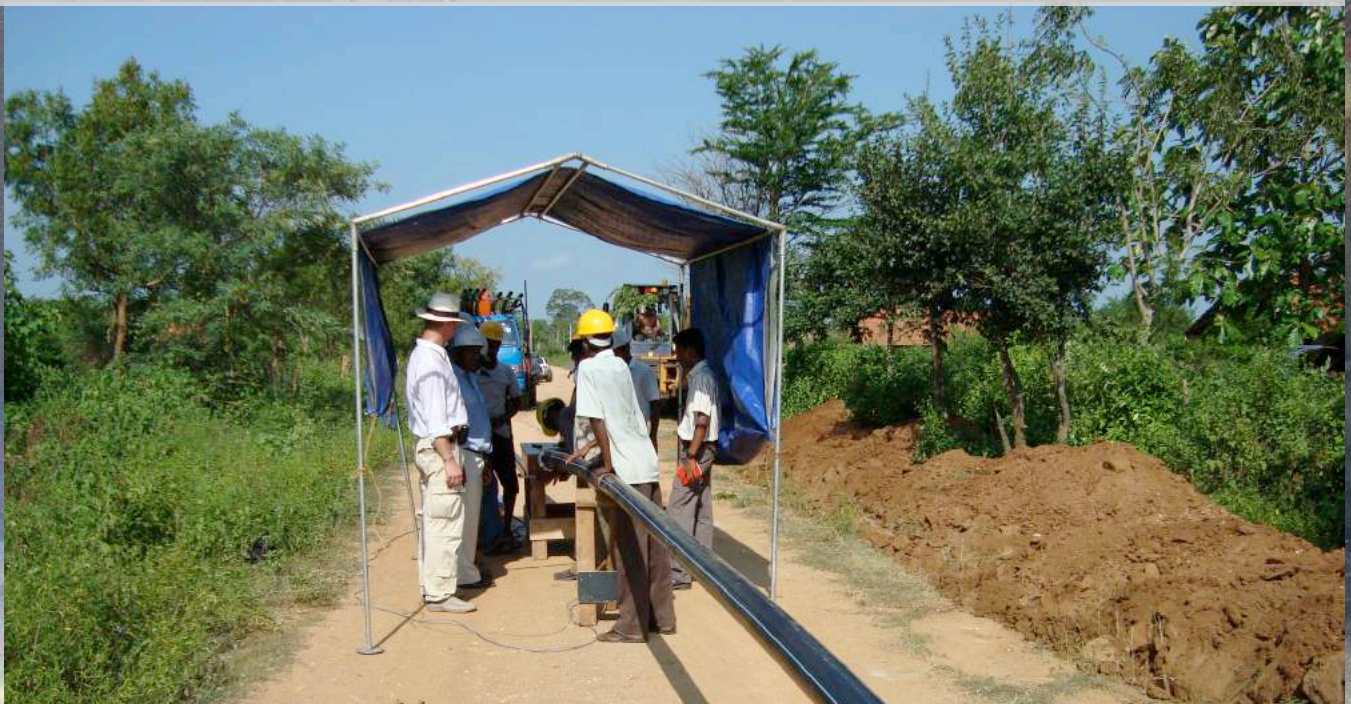
Schweißung in einem Schweißzelt unter DVS Beaufsichtigung Welding in a welding tent acc. DVS welding guidelines
