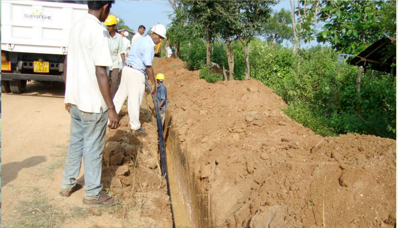
Baugrubeninstallation mit Sandeinbettung Trench installation with sand embedding
